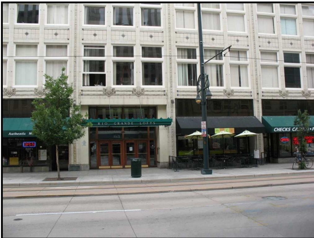
Rio Grande Lofts, 1531 Stout St., Ste. 100, Denver, CO 80202
